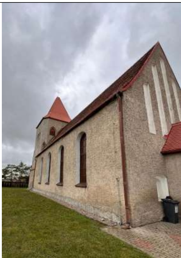
fot. 7 Ściana południowa i wschodnia, zawilgocenie powstałe na skutek wody odpryskowej i nieprawidłowego orywnowania
