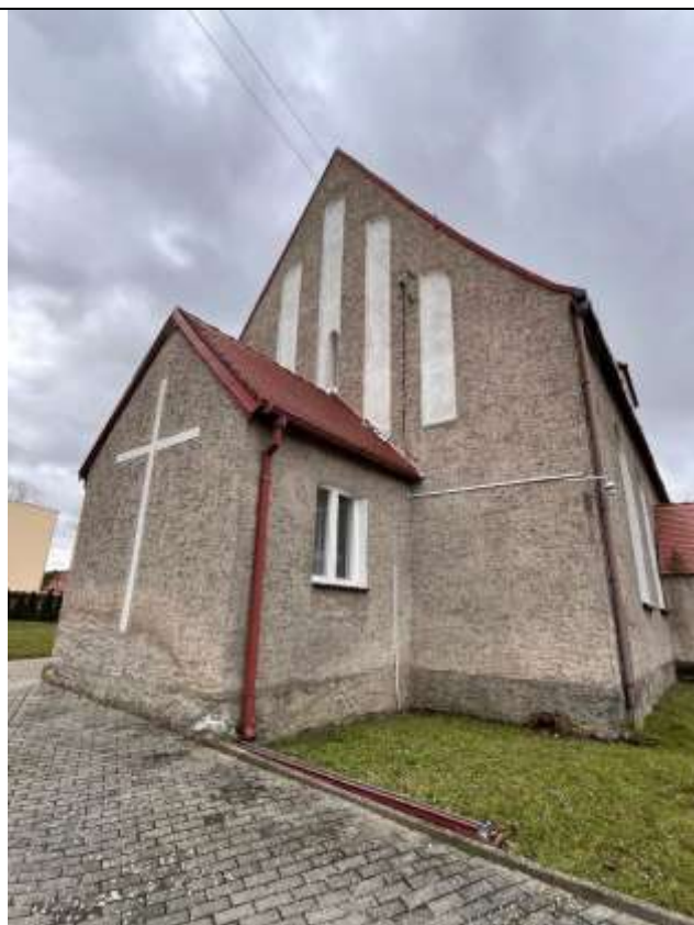
fot. 8 Ściana wschodnia, zawilgocenie powstałe na skutek wody odpryskowej
