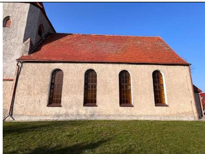
fot. 10 Ściana południowa, widoczne ubytki dachówek pokrycia dachowego korpusu kościoła
