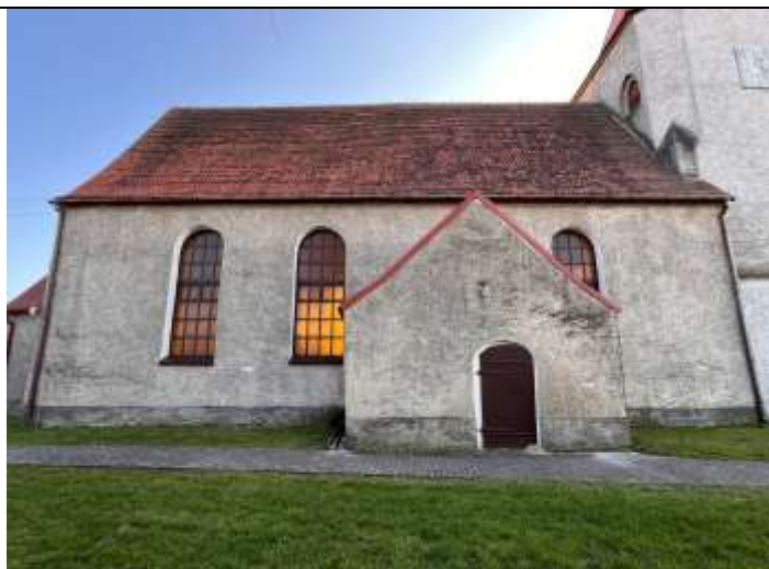
fot. 9 Ściana północna, widoczne kolonie grzybów i porostów pokrywające dach korpusu kościoła
